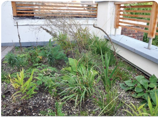
Sur cette toiture située à l'ombre, la végétation atteint jusqu'à seize centimètres au mois d'octobre
