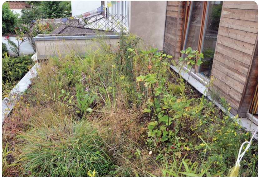
Un exemple de végétalisation de toiture dans une zone mi-ombrée ; en juillet, la végétation atteint jusqu'à vingt centimètres de haut
